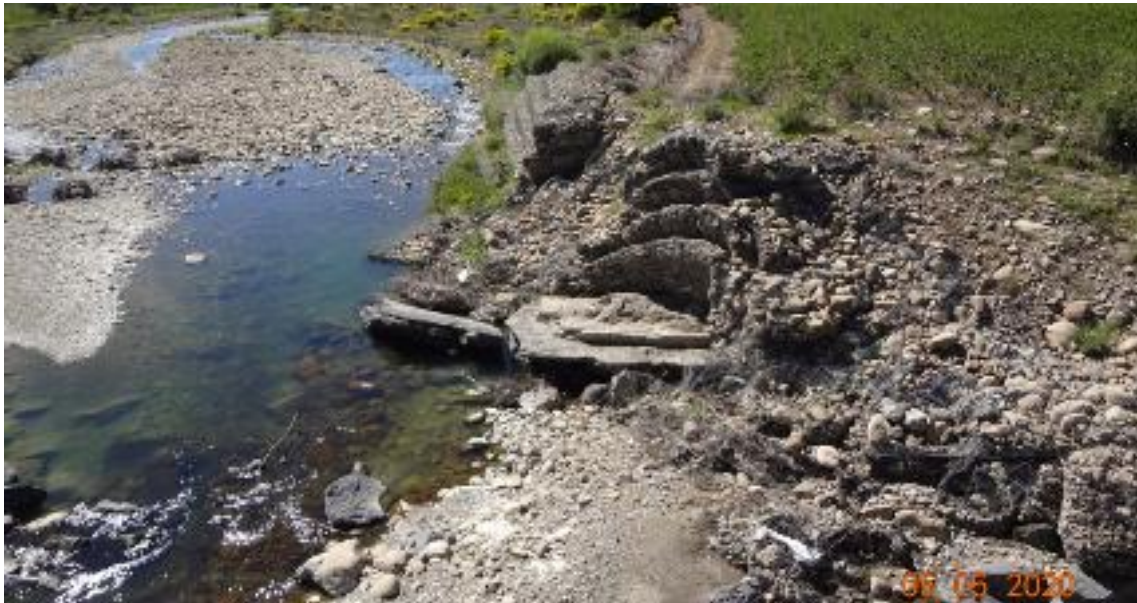
Rilievo Fotografico Fiume Simeto – c.da Serra – Ponte Bolo
